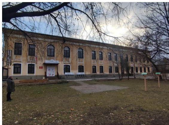
Проверка бюджетных средств, направленных на капитальный ремонт кровли и замену окон в здании МКОУ гимназия г. Слободского
