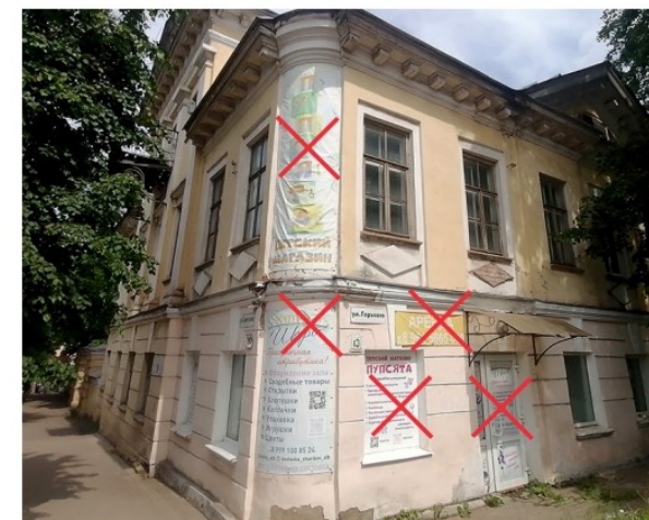
Баннерные полотна закрывают архитектурные элементы и оконные проёмы; рекламная информация закрывает стекло двери и оконных проёмов.
