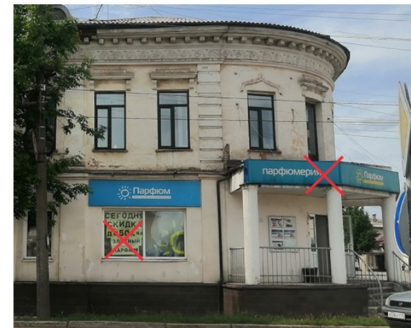
Вывеска закрывает архитектурные элементы здания; не профессиональная реклама в витрине
