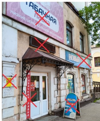
Штендер; баннерный щит на окнах; вывеска, размещённая в не предназначенном месте; медиаэкран; листовка на фасаде.
